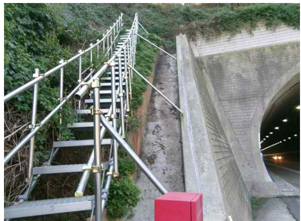
중점측 갭문 배수로 상태양호-문산방향
